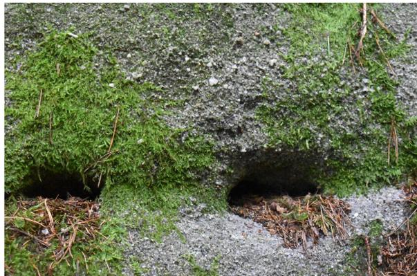
Bild 2: Wabenförmige Verwitterung
