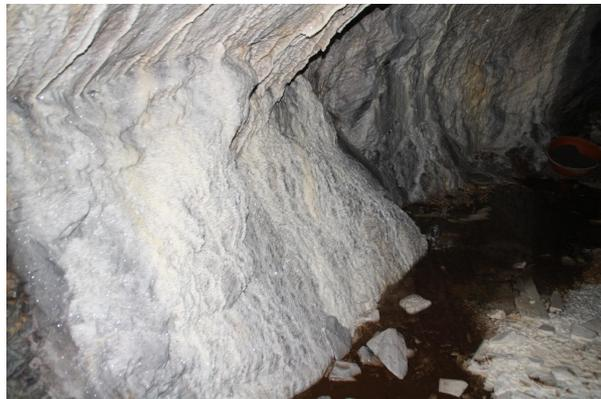
Bild 2: Überkrustete Seitenwand
