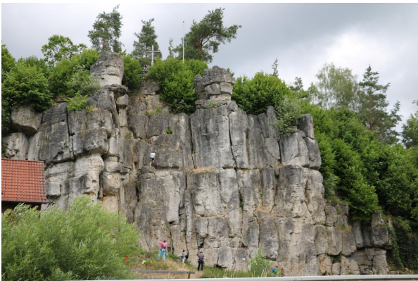
Bild 1: Die Felswand liegt direkt an der Hauptstraße.
