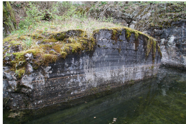
Bild 2: Gesägte Bruchwand im Marmorbruch am Rauheberg
