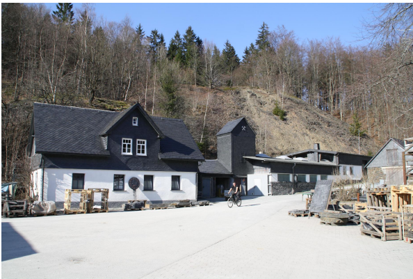
Bild 1: Dachschiefergrube Lotharheil, Betriebsgelände
