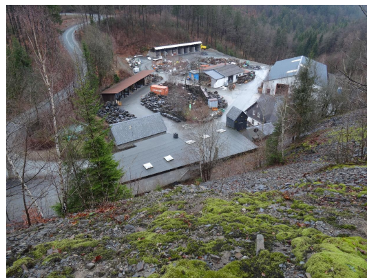
Bild 4: Dachschiefergrube Lotharheil, Gesamtansicht
