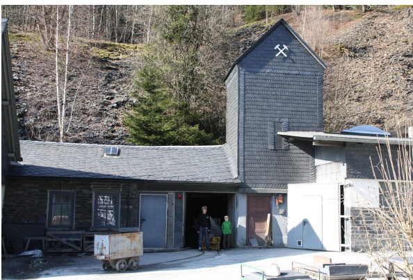
Bild 3: Dachschiefergrube Lotharheil, Stollenmundloch
