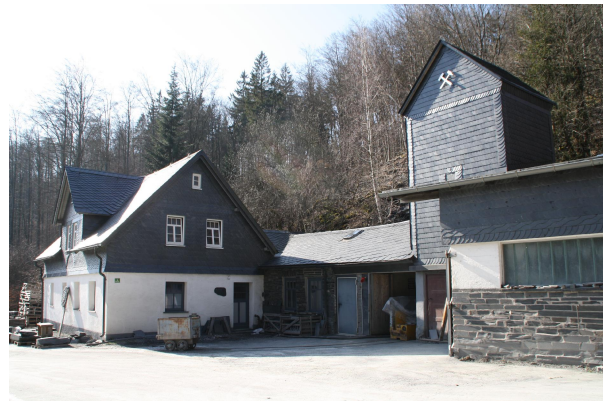
Bild 2: Dachschiefergrube Lotharheil, Betriebsgelände
