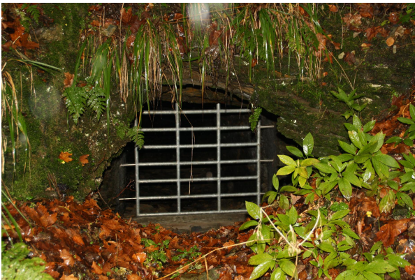
Bild 1: Versuchsbergbau auf Griffelschiefer im Lamitztal, vergittertes Mundloch
