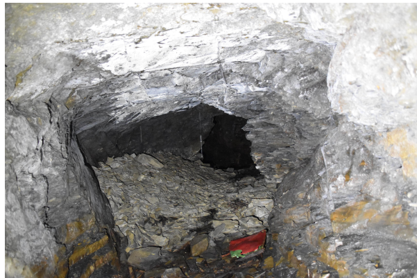
Bild 2: Blick von der Ortsbrust zum Mundloch hin
