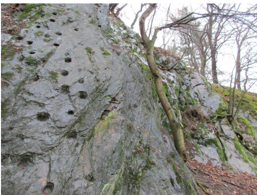
Bild 3: Löcher für Arbeitsbühnen (Foto: Georg Loth)
