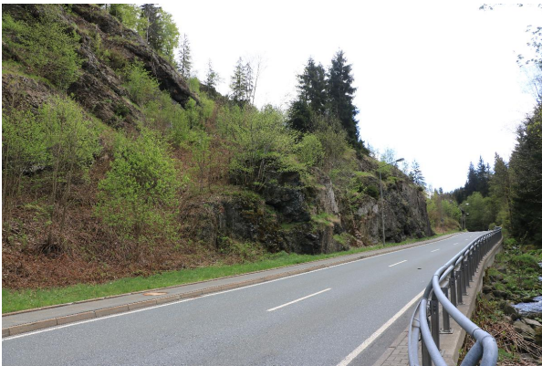
Bild 1: Aufschluss direkt an der St2198
