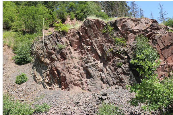
Bild 2: Steil einfallende Grauwackebänke
