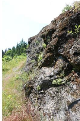
Bild 2: Hanganriss entlang des Wanderpfades auf den Rollenberg.
