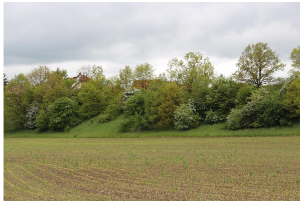
Bild 2: Die 10 Meter hohe Erosionskante
