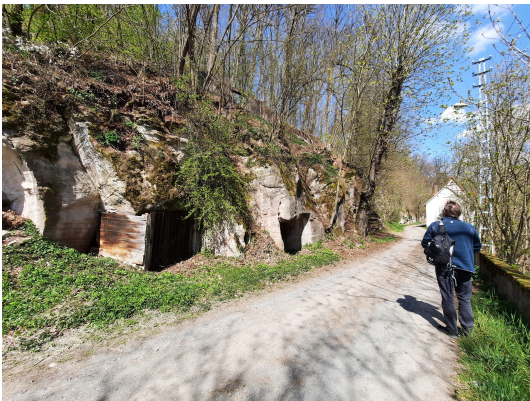
Bild 1: Felsenkeller beim Schützenhaus, Blickrichtung Nord
