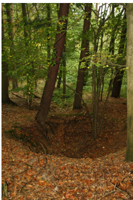
Bild 3: Zugang zum verfallenen Stollenmundloch des Bergbaus in W
