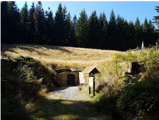
Bild 1: Stollenmundloch 2016 nach der Sanierung (Bild: Georg Loth)
