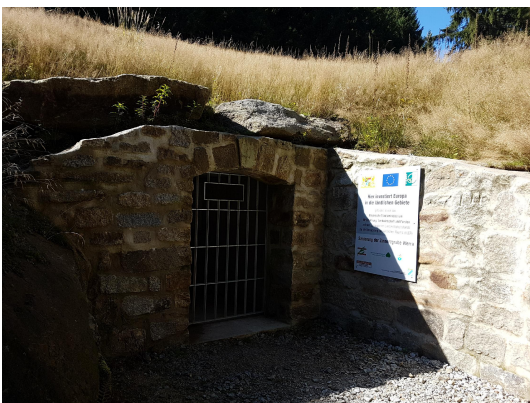
Bild 3: Stollenmundloch 2016 nach der Sanierung (Bild: Georg Loth)
