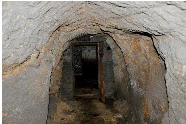
Bild 2: Blick in den Stollen
