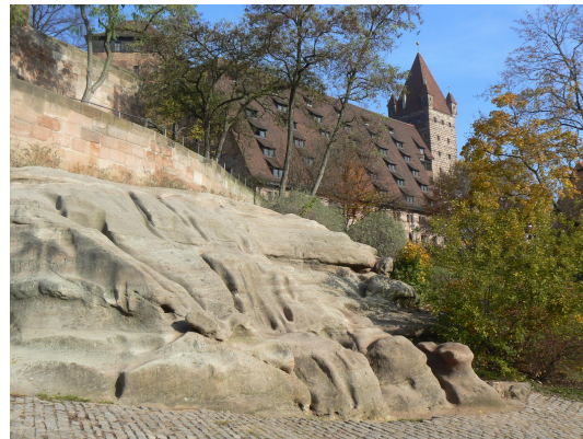
Bild 2: Härtere und weichere Stellen im Burgsandstein ergeben verschieden starke Abtragung, die sich hier zeigt.
