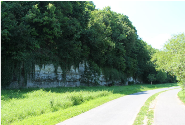
Bild 1: Blick vom Radweg auf den Prallhang (Foto: Georg Loth)
