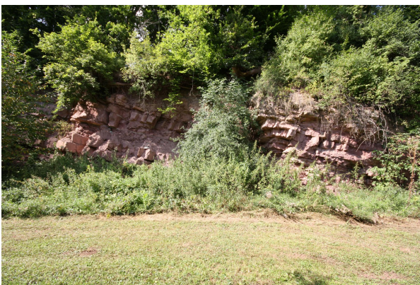
Bild 3: Foto mit Teleobjektiv von der Sandsteinwand
