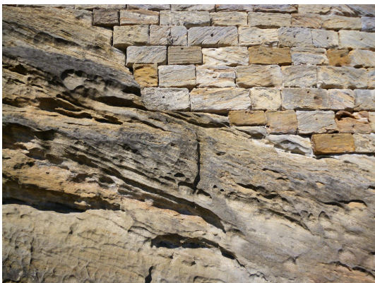
Bild 3: Mauer auf Fels mit verkippter Schichtung (Foto: Rosemarie Loth)
