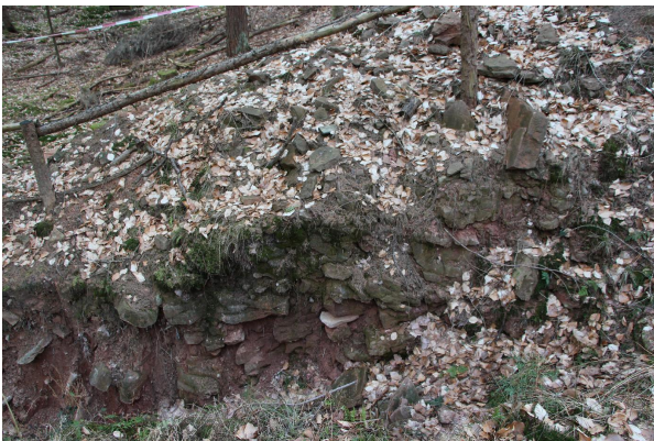
Bild 3: Blick in den Graben (Bild: Georg Loth)
