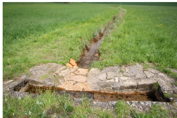
Bild 4: Im Frühjahr 2012 trat die Quelle nicht innerhalb der Quellfassung aus, sondern im Bachbett unmittelbar am Ende der Quellfassung. Deshalb lag der Überlauf der Quellfassung trocken.
