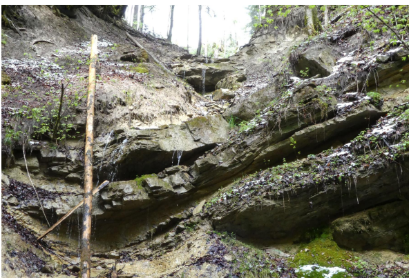
Bild 3: Blick tobelaufwärts vom Katzensteg
