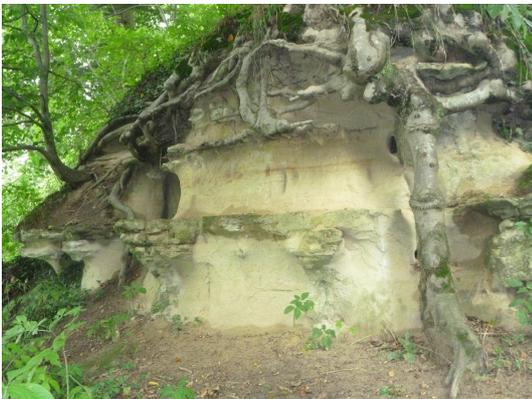
Bild 1: Sandsteinbank mit unterschiedlich harten Bereichen; freigelegte Wurzeln zeichnen Klüfte und Schichtflächen nach.
