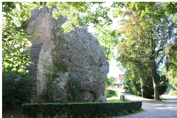
Bild 4: Der Mangoldfelsen trug einst eine Burg. Heute befinden sich eine Grundschule mit Spielplatz und ein Volkshochschulegebäude auf bzw an dem Geotop
