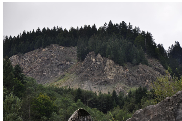
Bild 4: Abrissfläche oben: Allgäu- und Kössen-Formation
