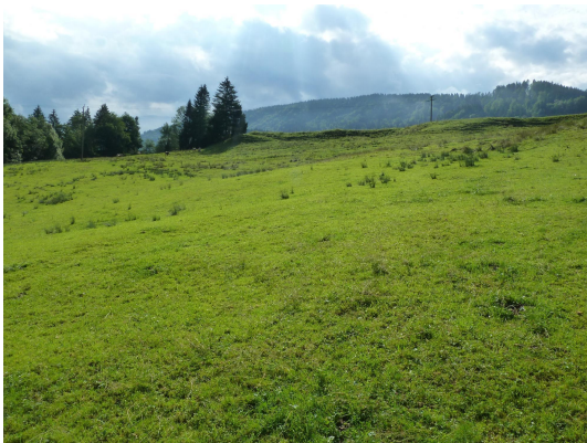
Bild 1: sekundärrutschung im unteren westlichen Teil
