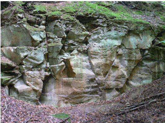
Bild 1: Mit Brüchen durchzogene Sandsteinwand im Steinbruch
