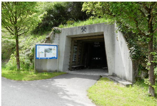
Bild 1: Einhausung ("Stolleneingang") des Aufschlusses
