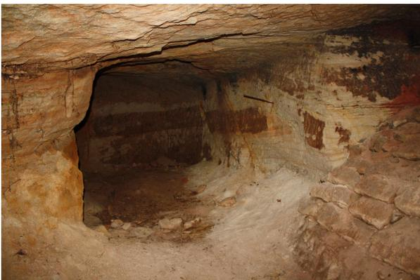
Bild 3: Kellernische mit durch Störungen versetzten Sandsteinen.
