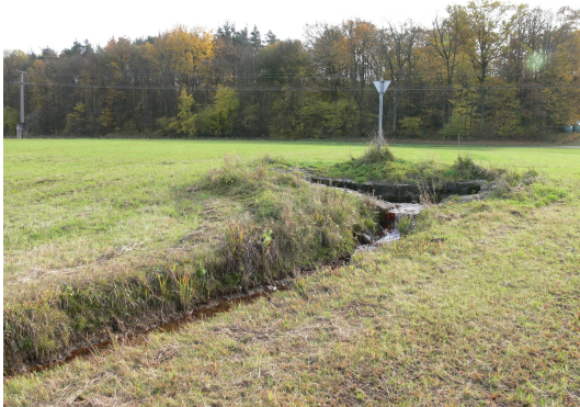
Bild 1: Übersicht des Areals mit Quelffassung
