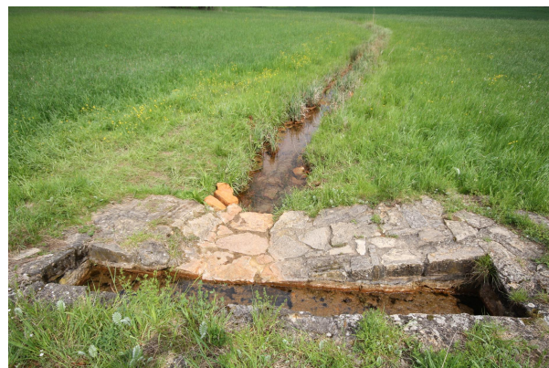
Bild 4: Im Frühjahr 2012 trat die Quelle nicht innerhalb der Quelffassung aus, sondern im Bachbett unmittelbar am Ende der Quelffassung. Deshalb lag der Überlauf der Quelffassung trocken.
