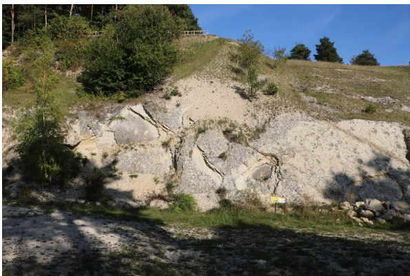
Bild 3: Der Steinbruch bei Gosheim mit stark zerrütteten Kalksteinen des Weißjura (Blickrichtung Osten)
